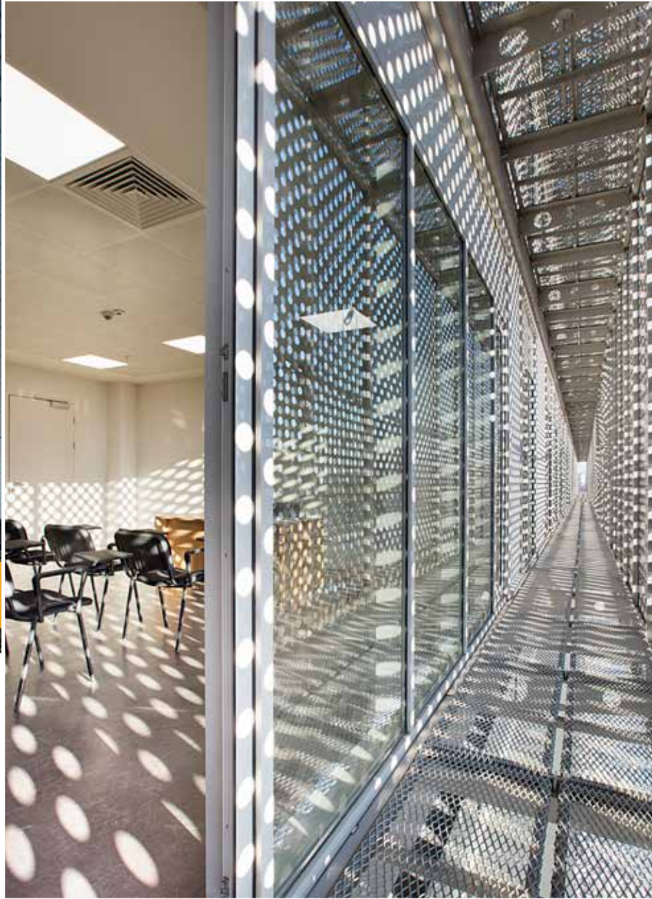
Avrasya Tüneli Operasyon ve Bakım Merkezinin Yan Perfore Metal Cephesi
